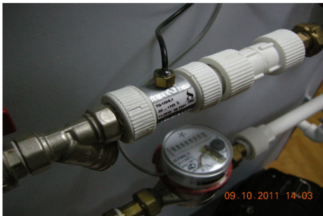
Установка термометра на трубопроводе
